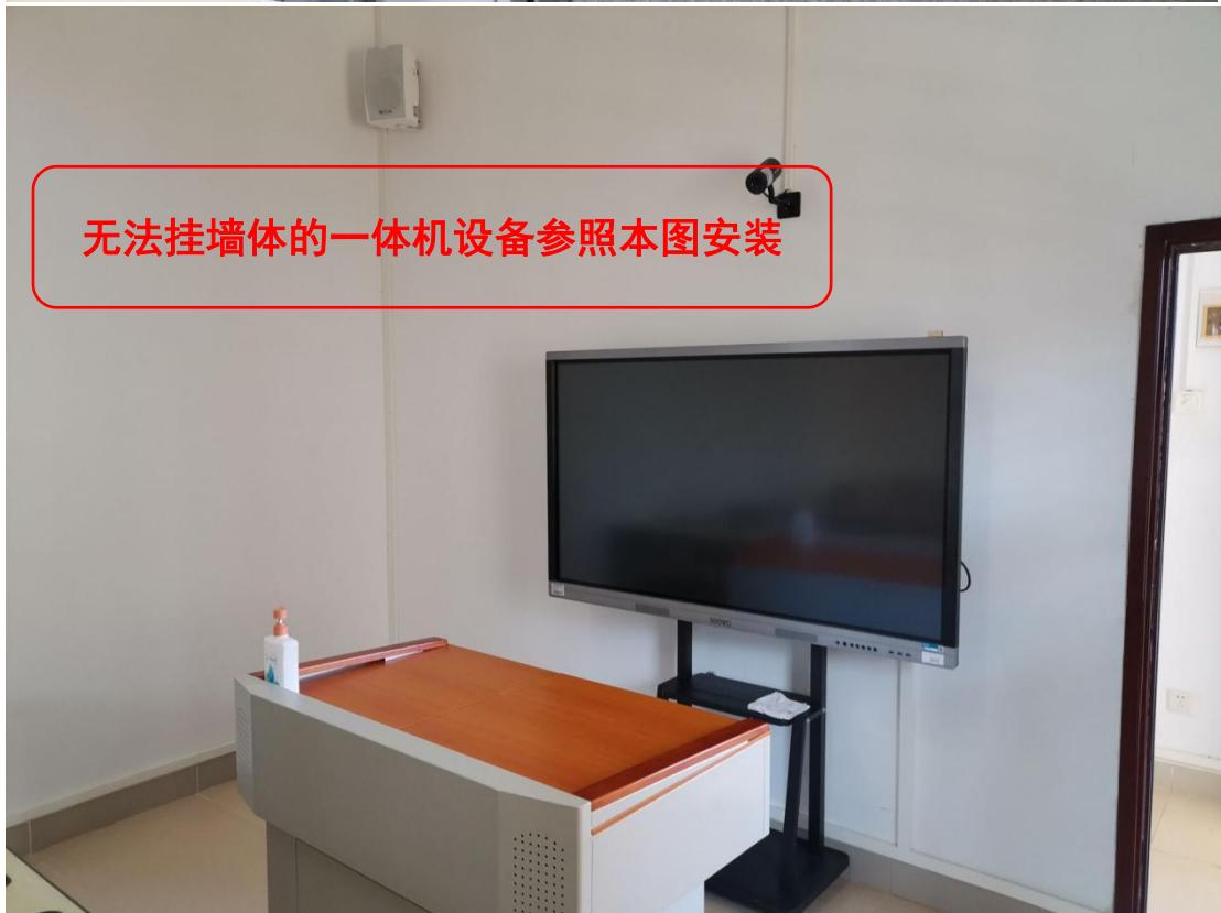
无法挂墙体的一体机设备参照本图安装
